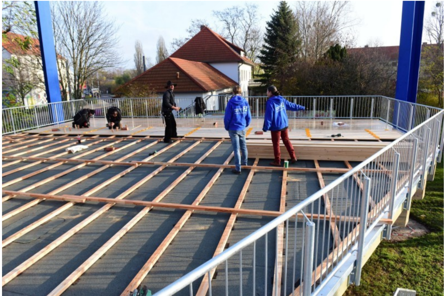
Im Zentrum für soziales Lernen am Schöppensteg wird weiter an der neuen Kletterkirche gearbeitet. Derzeit sind Zimmerleute dabei, die Hauptplattform mit einem Boden zu versehen. Voraussichtlich ab Sommer 2021 soll geklettert werden können. Foto: Uli Lücke
